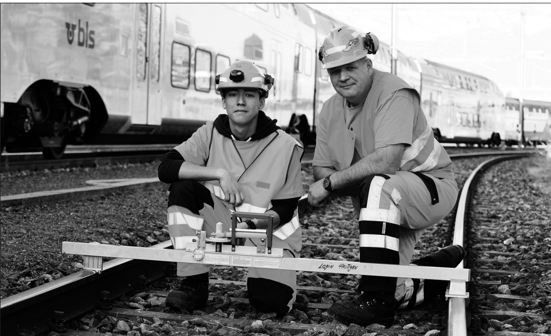
Arbeitssicherheit ist das A und O: Kevin Xie und Stefan Heiniger beim Messen der Spurbreite.
